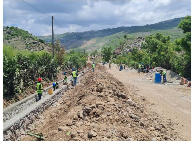
Sécuriser les excavations à l'aide des produits de fouille
