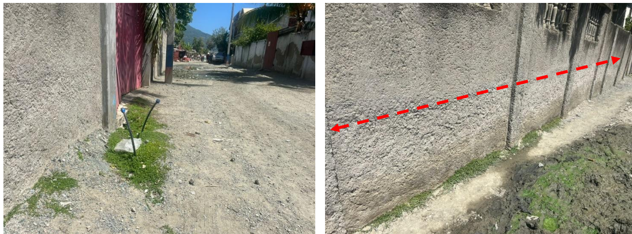
Figure 7 : Installation de la DINEPA et signature des inondations sur les adjacents à la route
