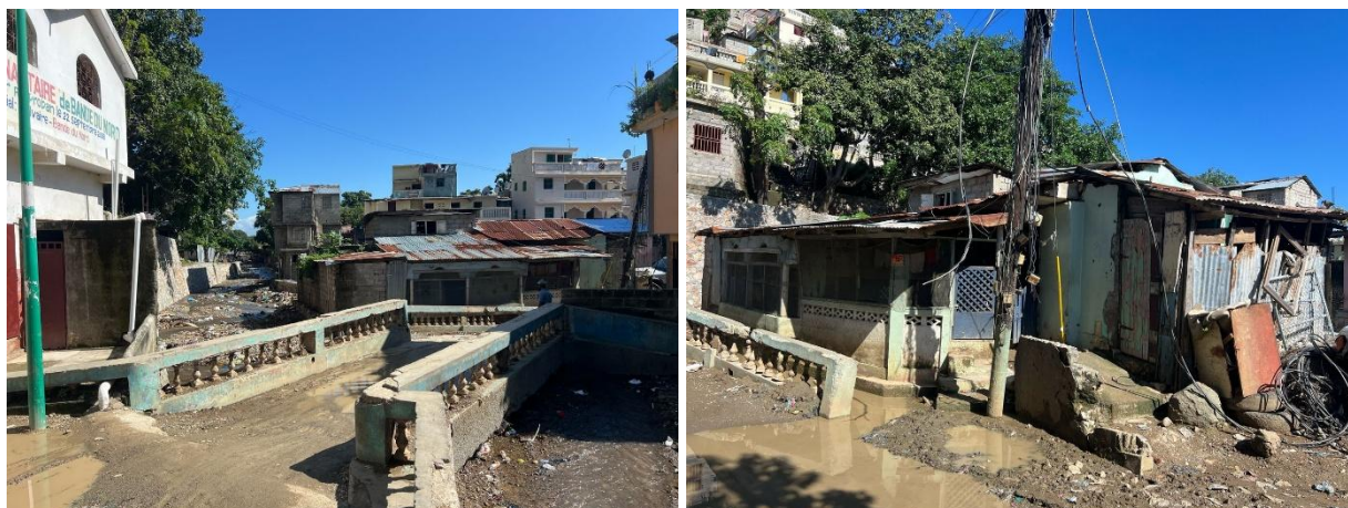
Figure 5 : Débordement de la ravine Belle-Hôtesse et les habitats autour
