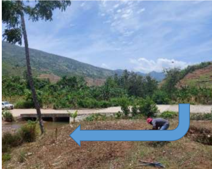
Figure 1 : Vue du dalot existant et de la déviation temporaire de la route (flèche bleue)
