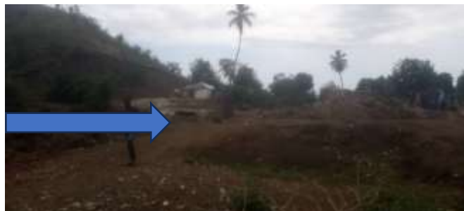
Figure 3 : Vue de la déviation temporaire de la rivière durant les travaux (flèche bleue)
