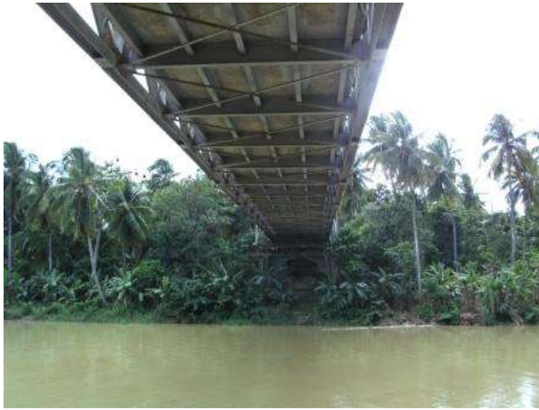
Pont Dumarsais Estime (RN7)
